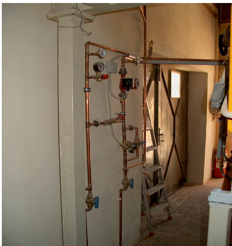
5.1. sz. kép: A BRIK B70 típusú brikettáló gép hűtökörének kialakítása a falsíkon, illetve a fejhűtés közeli nézete
