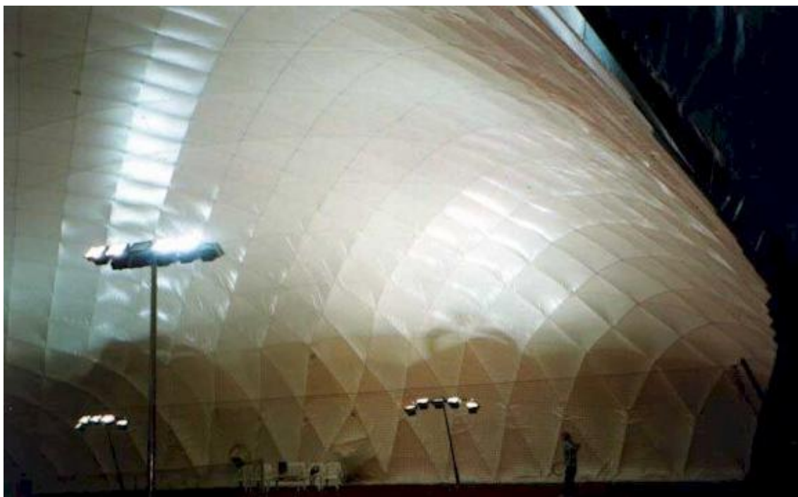
15. ábra. Kötélhálóval erősített légsátor belső tere, Budapest [15]
