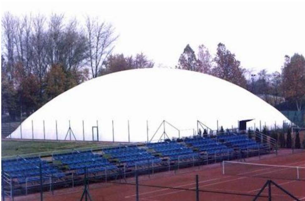
13. ábra. Kötelerősítés nélküli teniszcsarnok külső képe, Szeged [15]
