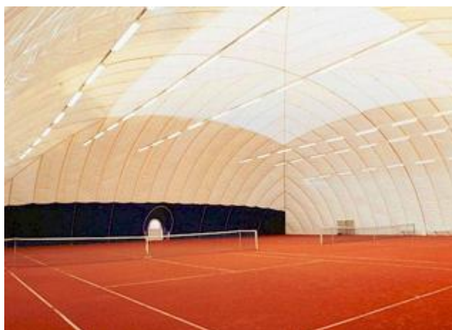
14. ábra. Kötélerősítés nélküli teniszcsarnok belső képe, Szeged [15]
