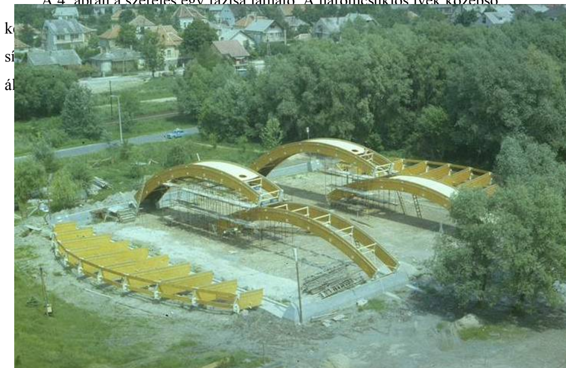
4. ábra. Keszthelyi teniszcsarnok egyik szerelési fázisa [15]
