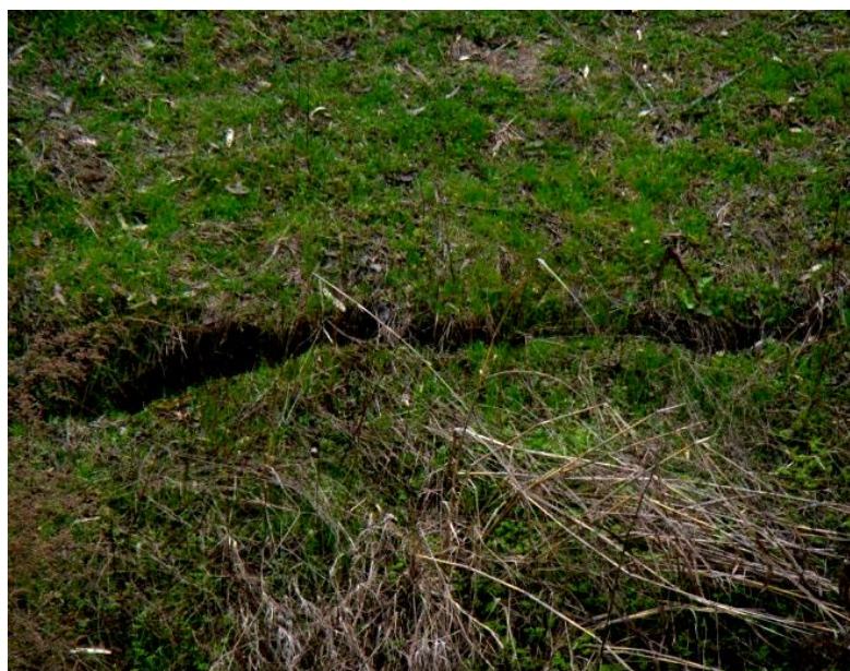
58. ábra. Az „a” területen található repedések (2010.03.23. Dunaszekcső) (forrás: szerző)
