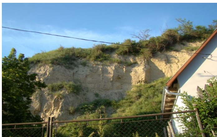
15. ábra. Partfal a lakóépületek közvetlen környezetében
