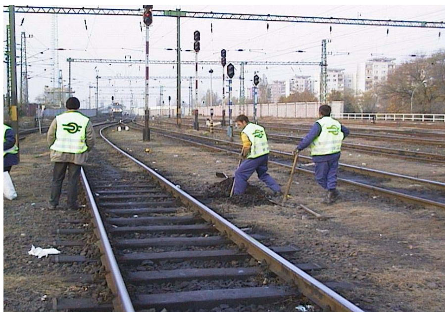
3. kép: Olajszennyeződés gyakori mozdonyállásnál
