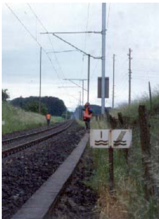
2. kép: Vízbázis fölött haladó vasútvonal
