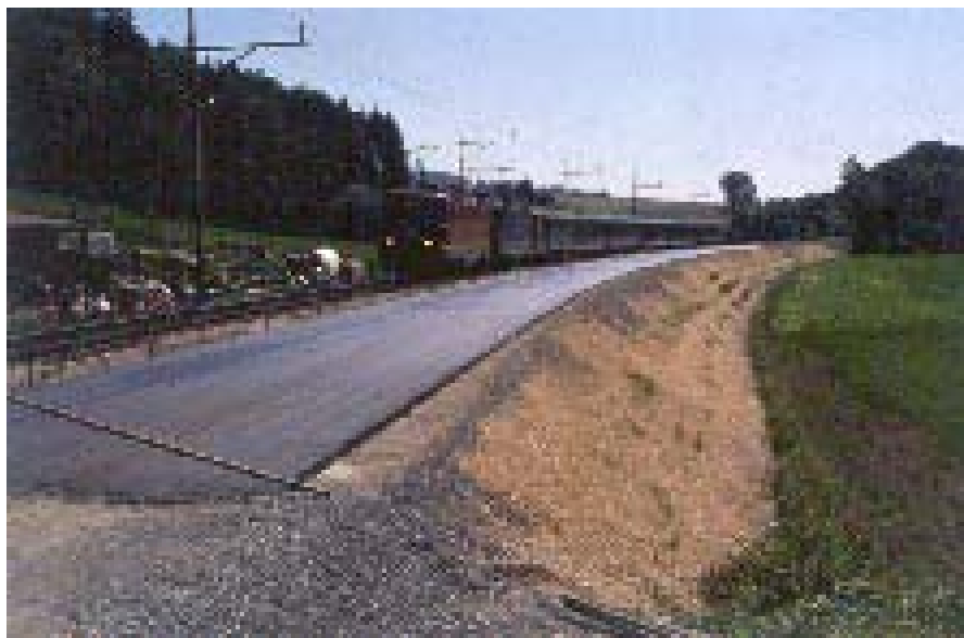
1. kép: Aszfaltburkolat vasúti felépítmény alá
