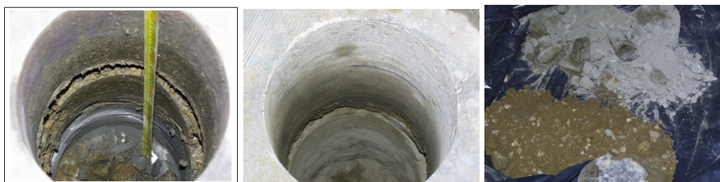
69. ábra. Üregesedés az ágyazat és beton között, az ágyazóréteg hiánya, a kétféle anyagú, eltérő ágyazórétegek bemutatása (fotó TÖRÖS)
